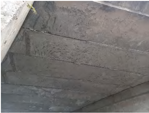
主梁空心板底混凝土剥离、露筋锈蚀、铰缝脱落
