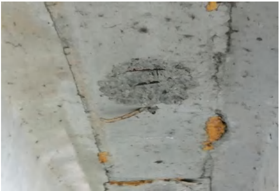
湿接缝破损露筋
