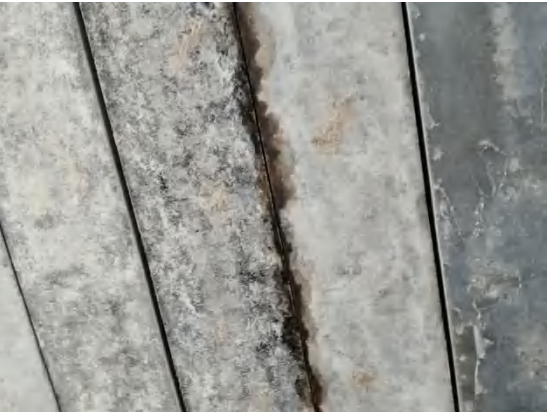
湿接缝破损露筋
