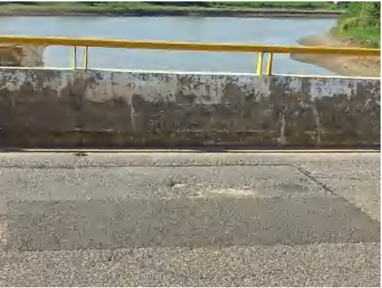
护栏涂装剥落风化
