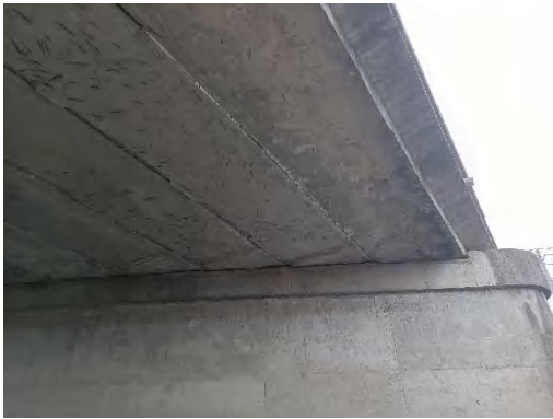
主梁空心板底混凝土剥离、露筋锈蚀、铰缝脱落
