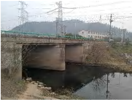
桥梁现状立面
