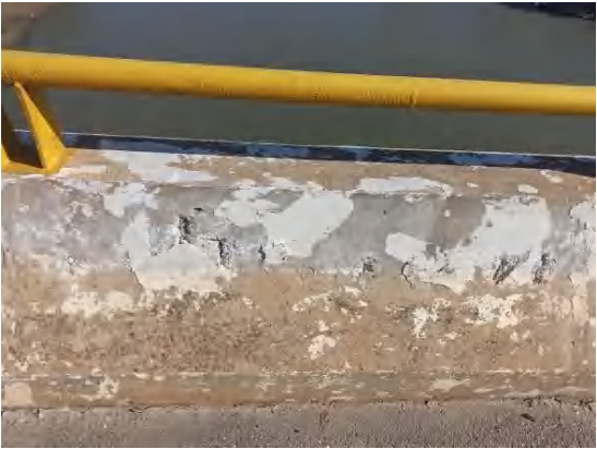
破损露筋
