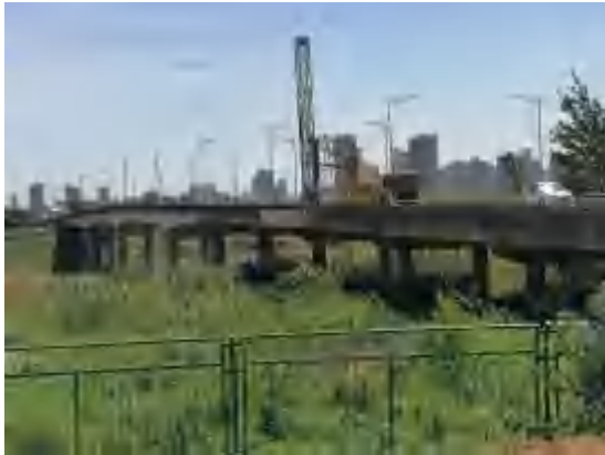
桥梁现状立面
